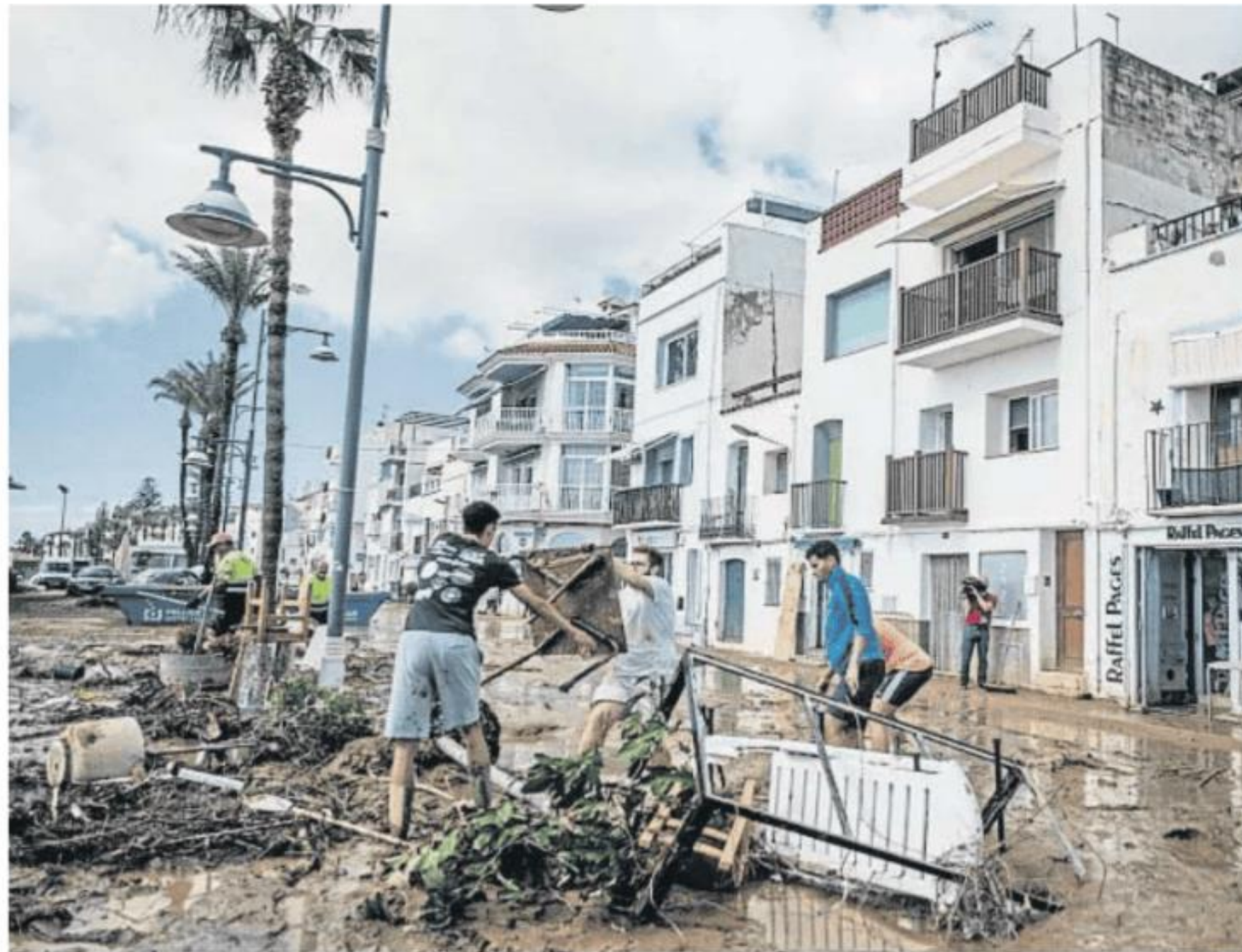
Las inundaciones causaron en el 2021 cuantiosos daños materiales en el municipio turístico de Alcanar
